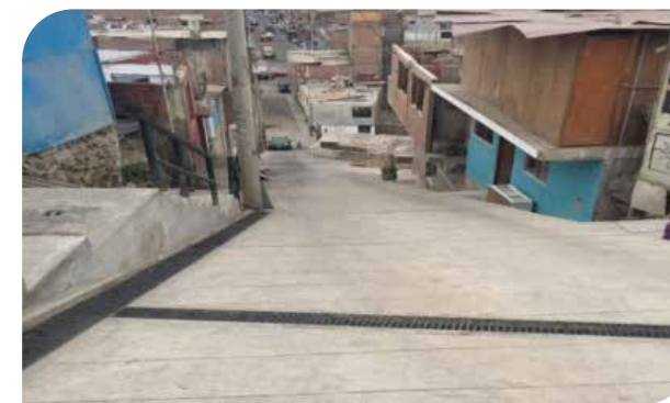
Vereda terminada y cuneta con rejilla metálica de protección en la calle 4
